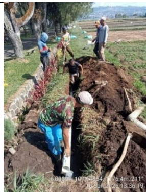
Perbaikan saluran air
